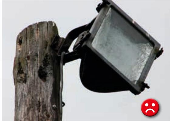
Holzmasten sind zur Prüfung im Erdbereich bis 60 cm Tiefe freizulegen und von dort aus bis 2 m Höhe abzuklopfen. Das Ergebnis ist schriftlich zu fertigen. *GUV-I 5136 beachten!*
