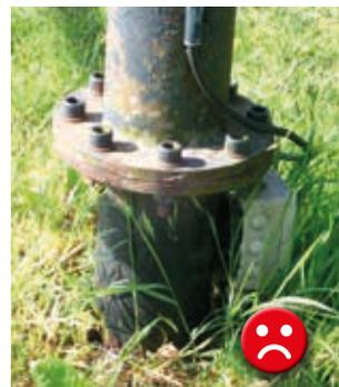
Elektrische Sicherheit ist aufgrund unfachmännischer Installation oder Zustand der Anschlüsse sowie fehlender Türen im Mast nicht immer vorhanden. Für Außenbereich unzulässige Kabel (weiß), Kunststoffdosen und Isolationsmängel sind oft festgestellt worden.
