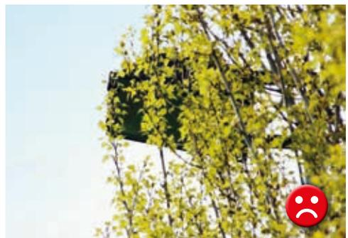
Bäume zu dicht am Spielfeld mindern die Lichtverteilung. Die Standsicherheit der Masten ist zu gewährleisten (GUV-V D 32 – UVV Arbeiten an Masten, Freileitungen und Oberleitungsanlagen).
