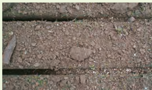
Verfüllung der Schlitze mit Kies
