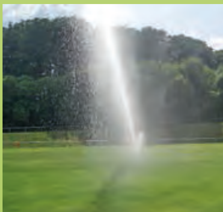
Mit der Versenkberegnung ist eine schlagkräftige Bewässerung des Sportplatzes möglich
