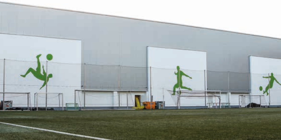
Die Fassade der SFV-Halle mit dem neuen Anstrich. (Foto: Alexander Rabe)
